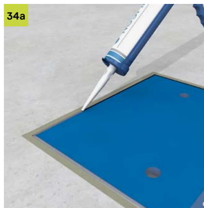
34a Um zu verhindern, dass Wasser oder Schmutz in die Kassette eindringen kann, Dichtungsmasse in die Fuge zwischen PCX-Deckel und Kassettenrand aufbringen.
