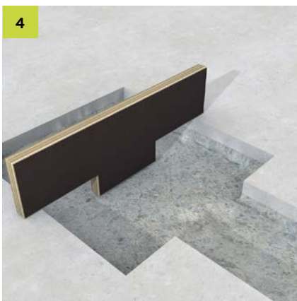
4 Qualität der Fräsung überprüfen. (Tiefenprüfer auf Anfrage)
