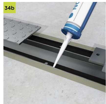
34b Zum Schutz vor Wasser und Schmutz Dichtungsmasse am Rand auf die Auflagefläche des Schwerlastkanals aufbringen, bevor der Schwerlastdeckel eingesetzt wird.
