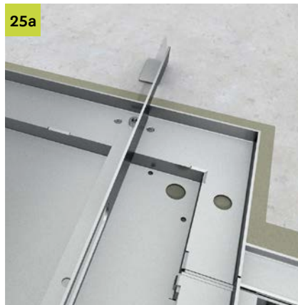
25a Überprüfen auf vollständige Unterfüterung mittels visueller Prüfung der Löcher der Kassettenauflagefläche.
