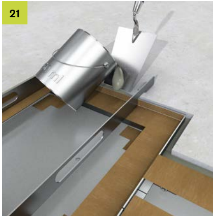
21 Verfüllung mit schnellhärtendem und schwindarmem Quellvergussmörtel oder Estrich für höchste Belastungen (s. Hinweis S. 11).
