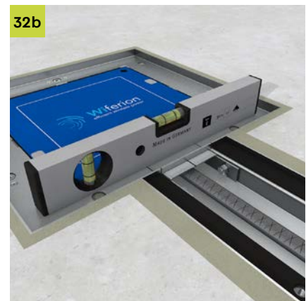
32b Der Schnellverbinder muss plan mit der Auflagefläche der Kassette sein.
