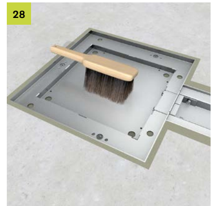
28 Vor dem Einlegen des Ladpads auf Verschmutzung kontrollieren und ggf. System reinigen. Kanal und Kassette müssen frei von Verunreinigungen/Fremdkörpern sein.
