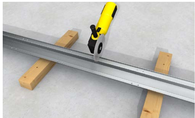
Kanalsegmente und Deckel zuschneiden und in Fräzzone auf Passung prüfen.
