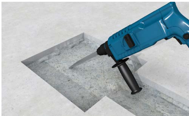
Unebenheiten mit einer Handfräse oder einem Stemmhammer ausbessern.
